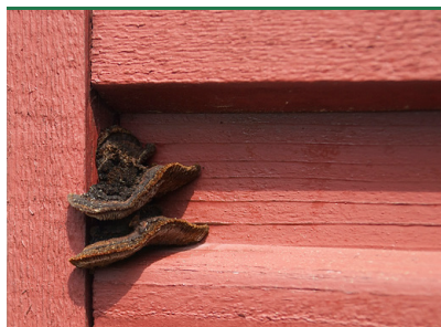
Korkhat - frugtlegemer på beklædningstræ, fritidshus. (Foto: Protox)
