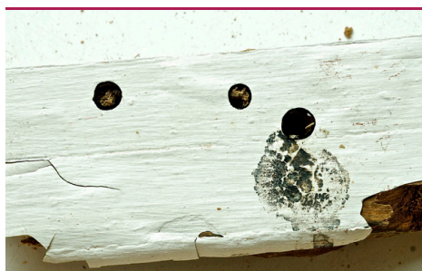
in 14 Rød Blomsterbuk - flyvehuller i dørkarm. (Foto: Protox/Goritas arkiv)
