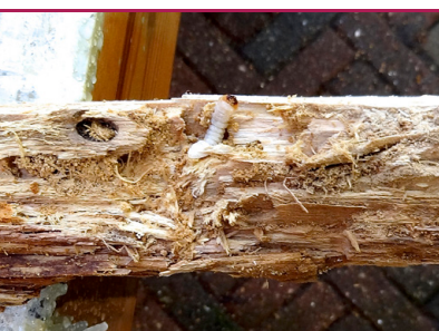
i 16 Rød Blomsterbuk i dørstolpe - larve og larvegange med boremel. Se også side 18. (Foto: Protox)
