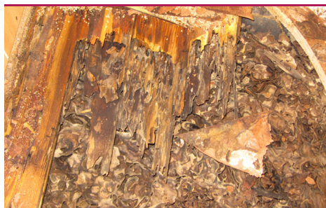
Orangemyrer - nedbrudte gulvbrædder. (Foto: Protox/kundefoto)
