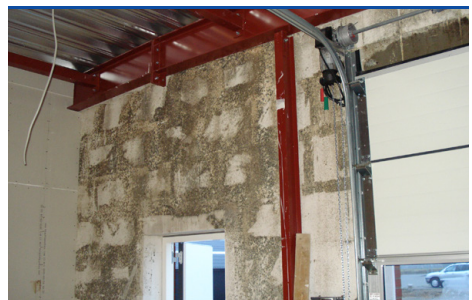
Skimmelvækst på nyopført væg i industrihal som følge af byggefugt. (Foto: Prottox)
