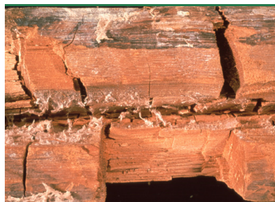
Ægte Hussvamp - sprækkeklodser. (Foto: Protox/Gori A/S)
