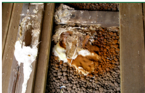
svn 4 Ægte Hussvamp - frugtlegeme, kakaolignende sporepulver og mycelium på lecanødder under gulv i udestue. (Foto: Protox/kundefoto)
