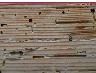
i 11 Alm Borebille - gulvbræt med frilagte larvegange som følge af afhøvling. (Foto: Protox)
