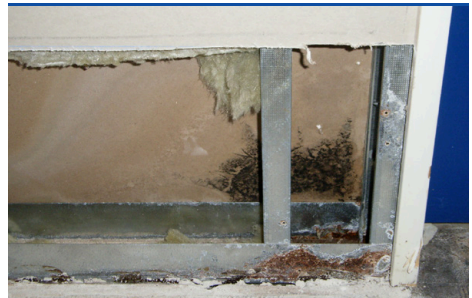
Skimmelvækst ( Stachybotris chartarum ) i let gipsvæg efter oversvømmelse. (Foto: Prottox)
